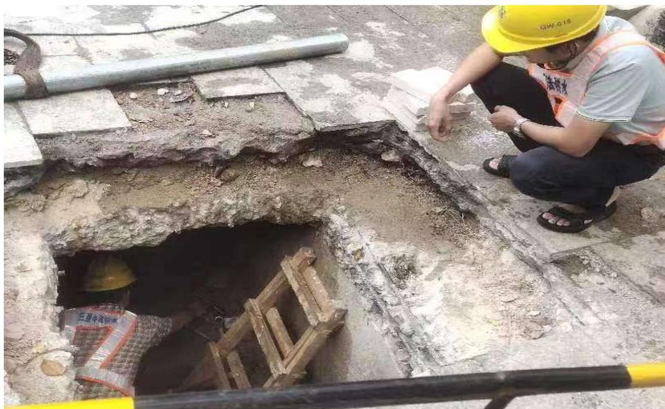
在更换阀门的过程中，管网部提前做了停水申请，并在施工前先挖好工作面，把旧阀门的螺丝等配件进行拆卸更换，同时装备好新阀门，尽可能缩短停水时间。为保证金鸡岭社区群众用水的水质，工作人员在实施阀门更换完毕后，在金鸡岭社区总表处进行排水作业，取得了良好效果。此次更换阀门后，金鸡岭社区的不再存在无法关闭水影响维抢修时间的问题，也解决了阀门堵后影响社区水压的隐患，对该社区供水安全提供了保证。（管网部 李玉海）
